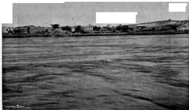
FIG. 12 a . — Abitazioni di operai italiani a Scellal.
