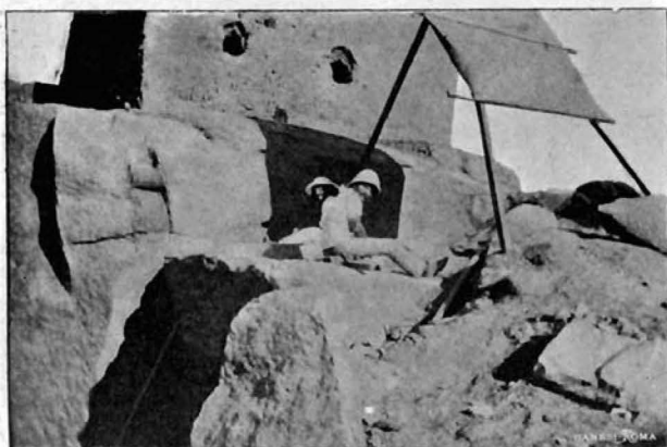
FIG. 13 a . — Operai al lavoro.
