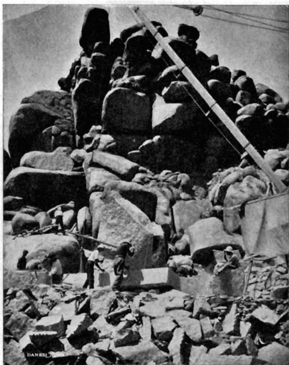
FIG. 10 a . — Taglio dei blocchi di granito.
