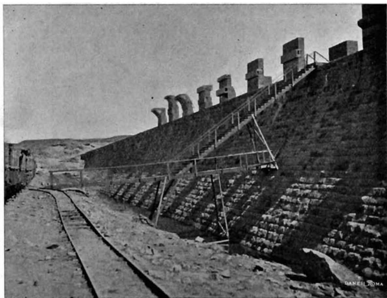
FIG. 4 a . — Muraglione del serbatoio a Scellal.
