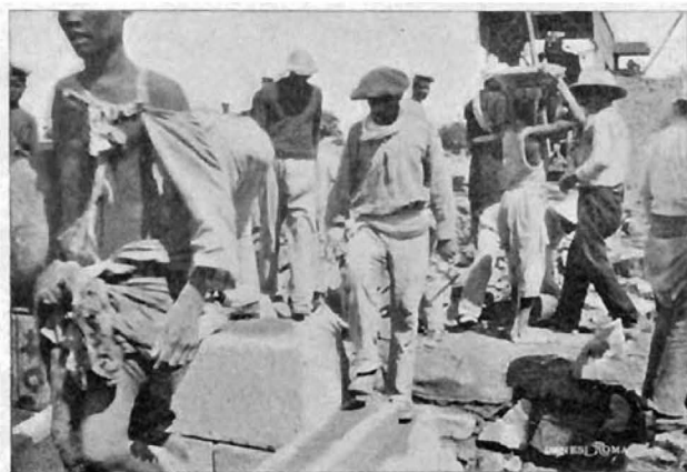
FIG. 14 a . — Cantiere a Scellal.
