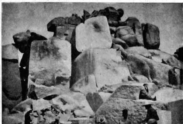
FIG. 11 a . — Taglio dei blocchi di granito.
