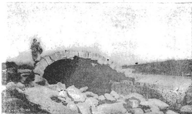
FIG. 21 a . — Serbatoio d'acqua a Saf-Saf.
