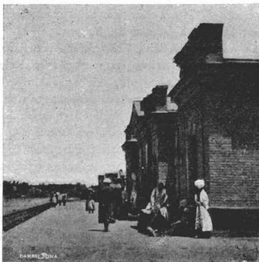
FIG. 1. a — Stazione della ferrovia transcaspiana a Tashkent.
