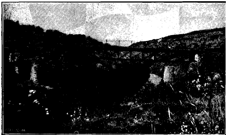
FIG. 20 a . — Regione Adal. Il ponte sull Hauash.
