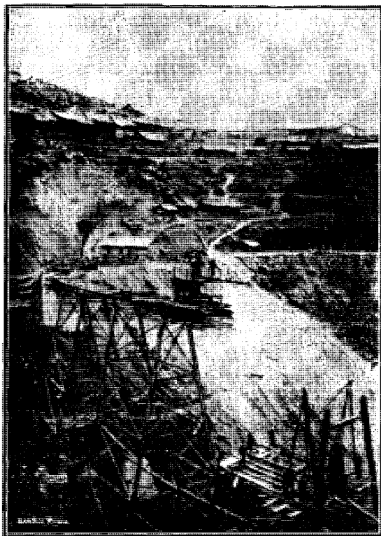
FIG. 24 a — Imponente viadotto metallico al km. 82. (Impresa Valz-Magnani).
