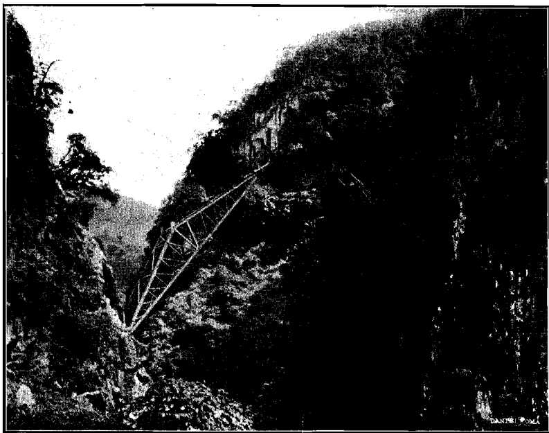
FIG. 21 a — Congiungimento dei due pezzi che formano un arco unico dell'ardito ponte d'acciaio sul torrente al km. 111.500. (Impresa Bozzolo e De Agostini).
