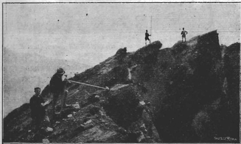
FIG. 9ª — Livellazione di precisione sull'orlo NE del cratere. (Fot. A. M.).
