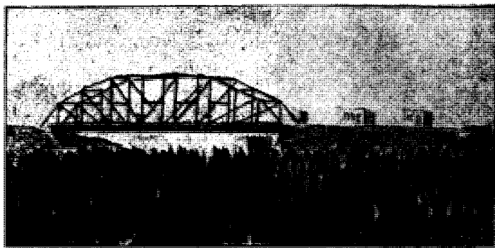
FIG. XIII. — Il ponte della ferrovia a Giulfa. (Veduta presa dal punto + dello schizzo).
