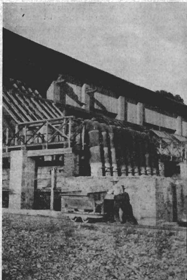
FIG. 6. - Vasche di raccoglimento del mercurio condensato nelle « alludelle » o tubi di condensazione (visibili al di sopra delle vasche).
