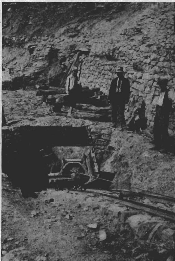
FIG. 2. - Cantiere della Banditella. Il carrello, tirato elettricamente a mezzo di una corda di ferro, esce dalla « discenderia » carico di minerale.
