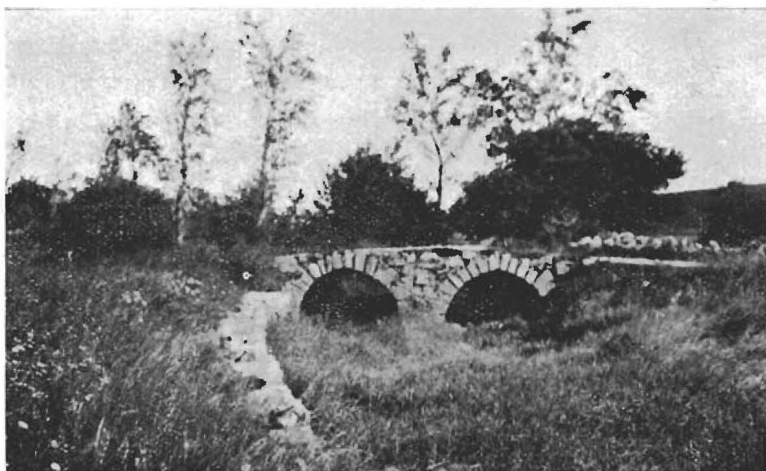
Fig. 6. — Ponte sopra l'incisione nei terreni alluvionali. a valle della Piana di Drescozze.
