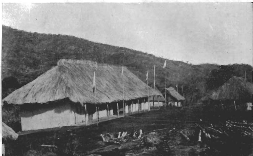
1. — Stazione missionaria italiana di Lerùà - La casa dei missionari.
