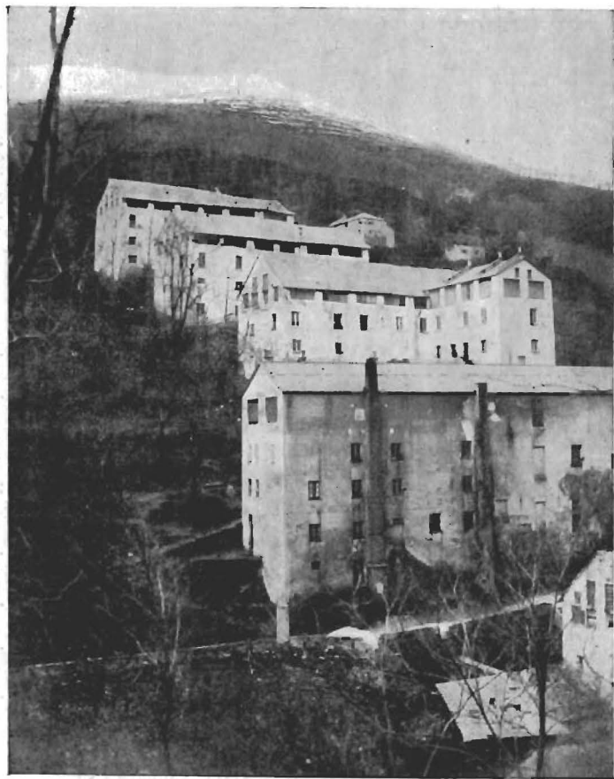
Salto idraulico di circa 42 m. utilizzato da cinque cartiere alla Biscaccia in Val Ceresolo; le due più in alto trovansi nelle condizioni primitive del secolo XVI; la terza ha sul davanti una parte aggiunta nel secolo XIX; la quarta è stata di recente rifatta dopo un incendio; la quinta è nelle condizioni primitive, probabilmente del secolo XV. Fotografia eseguita nel 1885.
