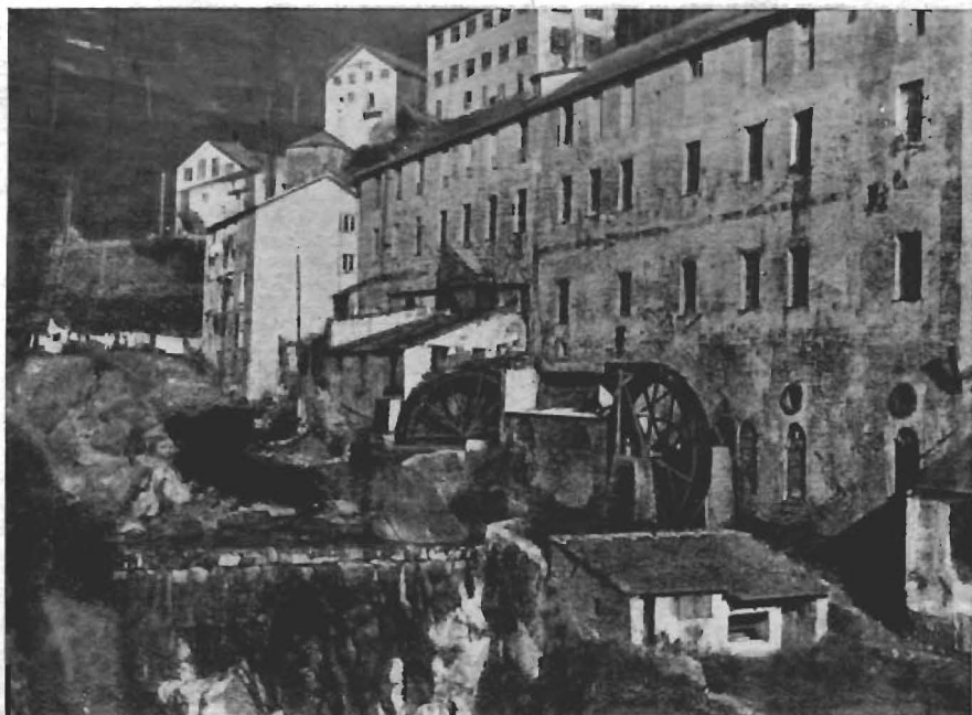
La cartiera di Gattedasea com'è attualmente: una ruota serve per la macchina , l'altra per i cilindri .
