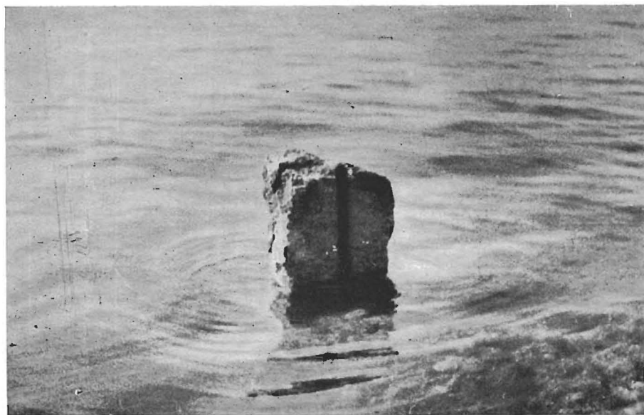
Fig. 4. — Formia, Sotto la Villa Colagrosso si trova una grande piscina romana, della quale diversi pilastri mostrano ancora l'incavo delle saracinesche che chiudevano i canali fra i bacini di piscicoltura ed il mare.
