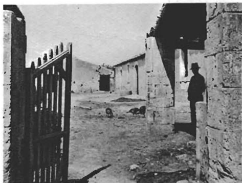
DAMMUSI - La corte: interno. In alto : La corte: esterno.
