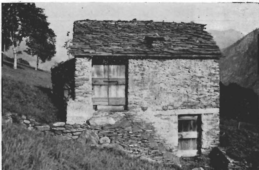
Questa cascina sopra Introzio in val Varrone, riassume le caratteristiche delle stalle-fienili del bacino lariano: la stalla è al pian terreno seminterrata, sovrapposto vi è il fienile; i muri son costruiti in pietre e calce; il tetto è di lase .
