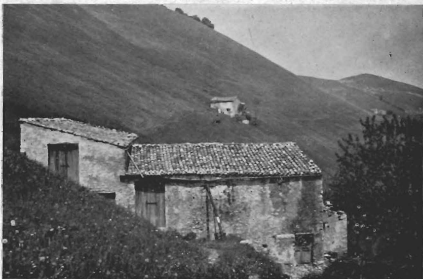
Cascine distribuite lungo il sentiero che attraversa i prati-pascoli sottostanti il Colletto in Val Fonteno (Lago d' Iseo). Si osservi il tetto di cotto, le grondaie ed i condotti per la raccolta dell'acque piovane.
