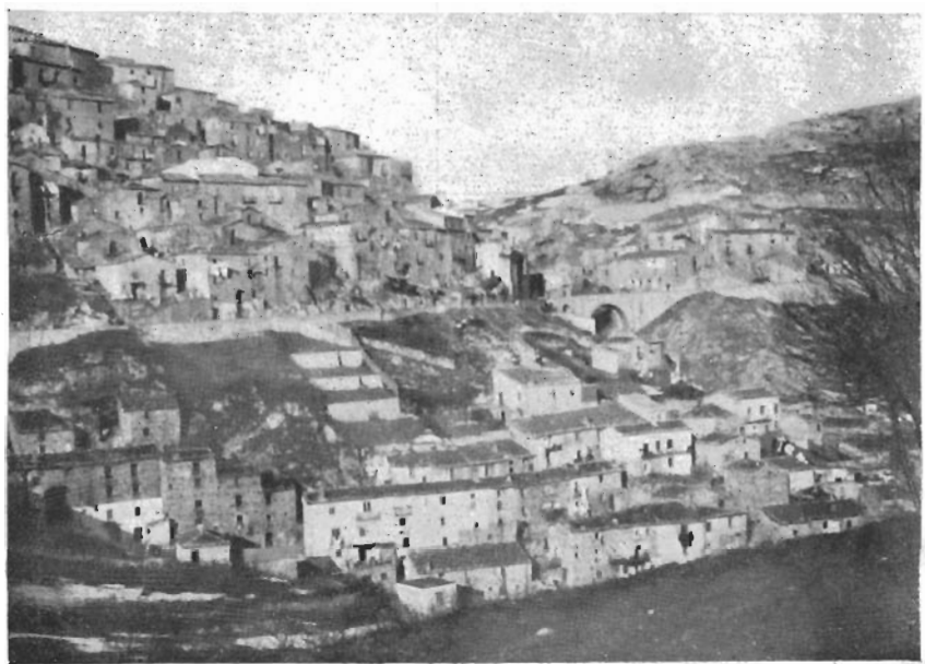
MARSICONUOVO - Centro di pendio
