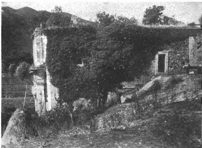
Stato attuale della chiesa di S. Vittorino
