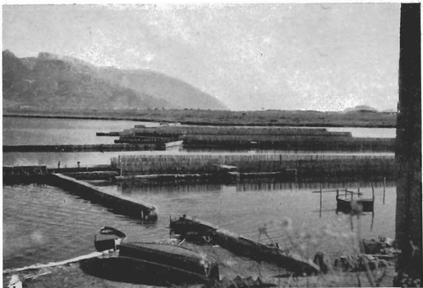
I tradizionali lavorieri di palafitte e canne lungo le dighe di sbarramento, invariate attrezzature della peschiera sarda (Tortolì).
