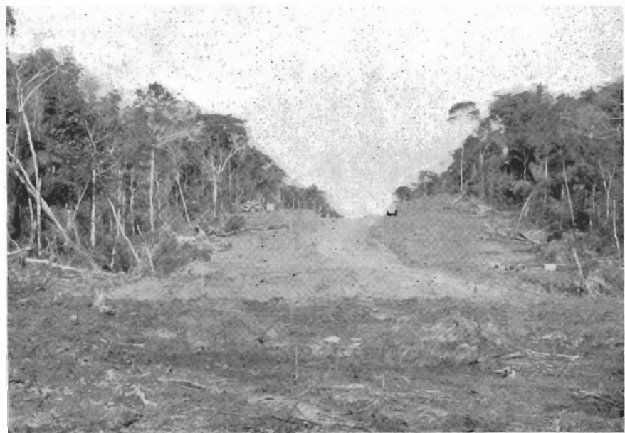
LA STRADA IN COSTRUZIONE PER PUCALLPA NELLA REGIONE DI TOURNAVISTA.
