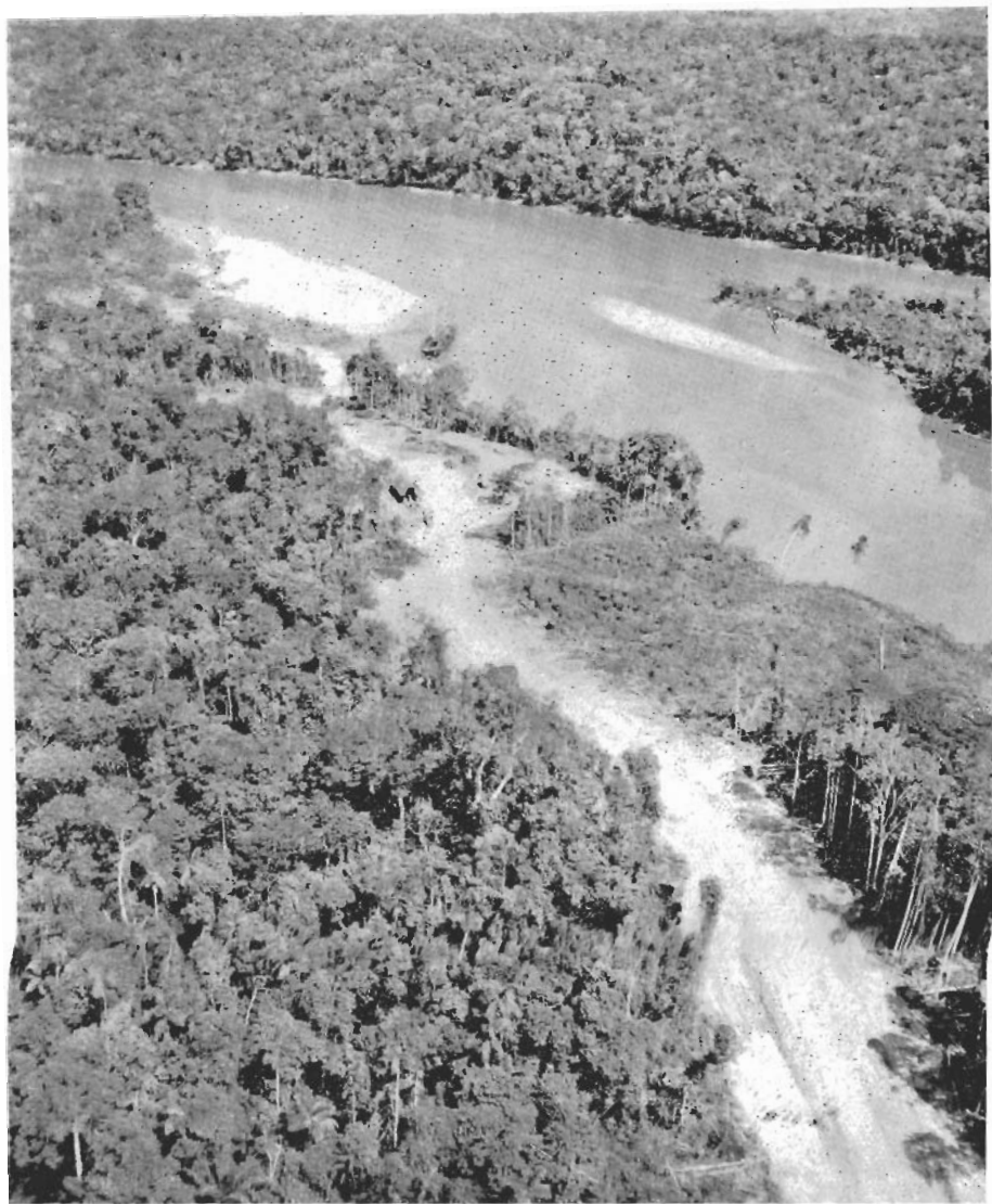
UN TRATTO DELLA STRADA IN COSTRUZIONE PER PUCALLPA, PRESSO IL RIO PACHITEA.
