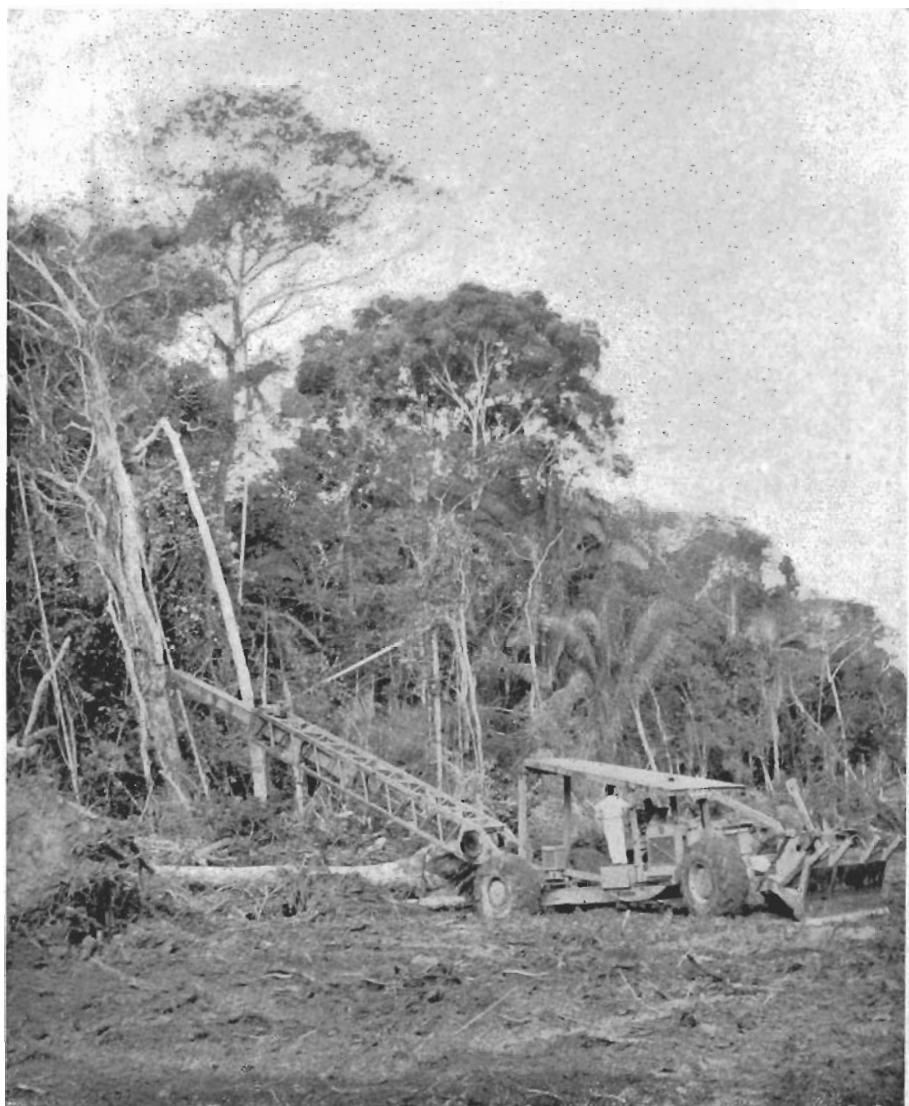
UN TREE PUSHER LE TOURNEAU AL LAVORO DI ABBATTIMENTO ATTRAVERSO LA FORESTA.
