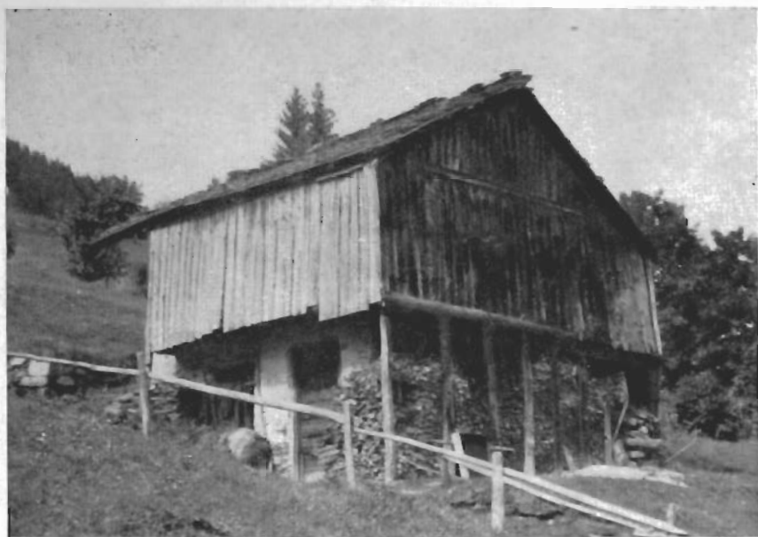
FIENILE ISOLATO, DI TAVOLE DI LEGNO, CON TETTO DI SCANDOLE, NEI DINTORNI DI AGORDO.
