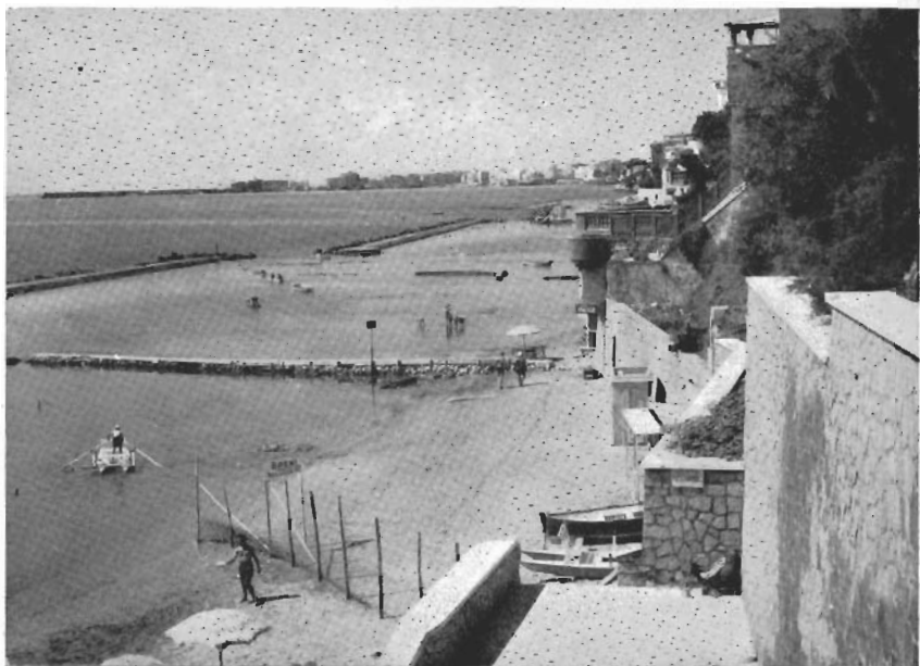
NETTUNO. Opere di protezione dell'arenile dall'erosione marina.
