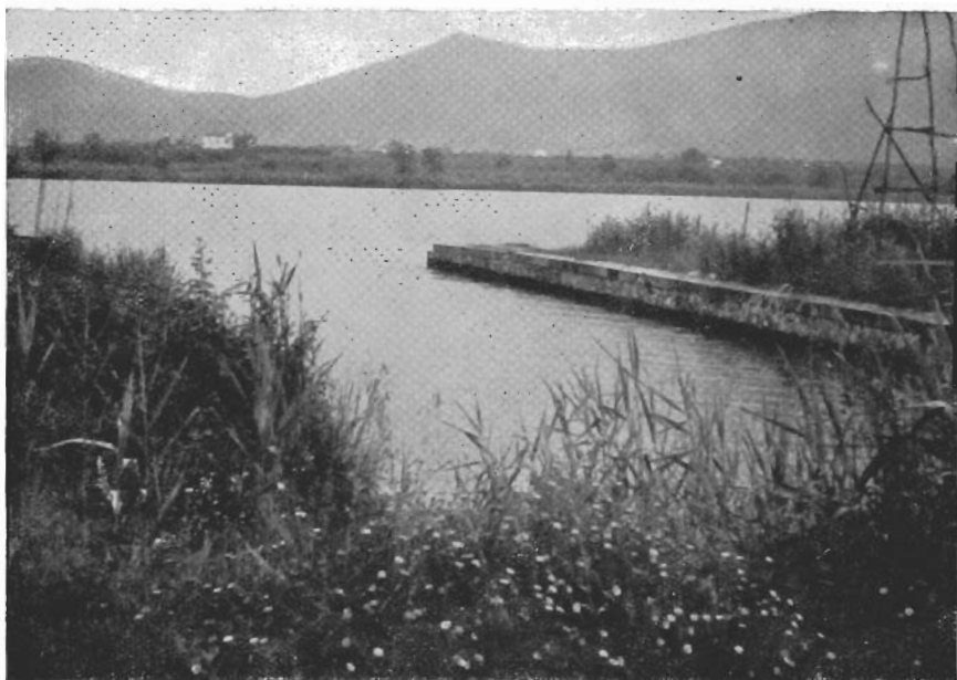
Lo sbocco nel L. Lungo della vecchia foce, ora parzialmente inutilizzata.
