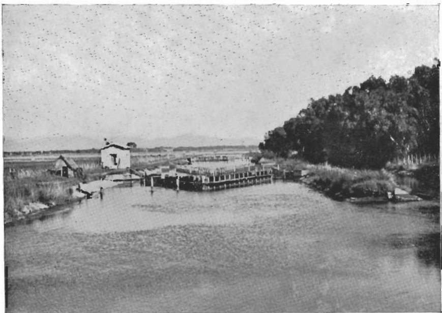
Lavorieri nella foce del L. dei Monaci.
