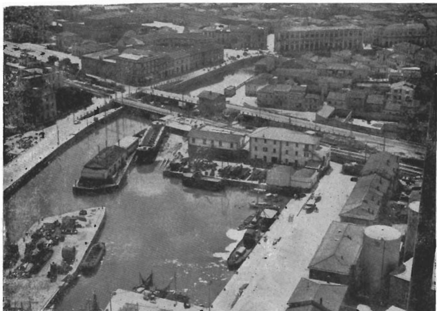
SENIGALLIA: VEDUTA PARZIALE DEL PORTO-CANALE.
