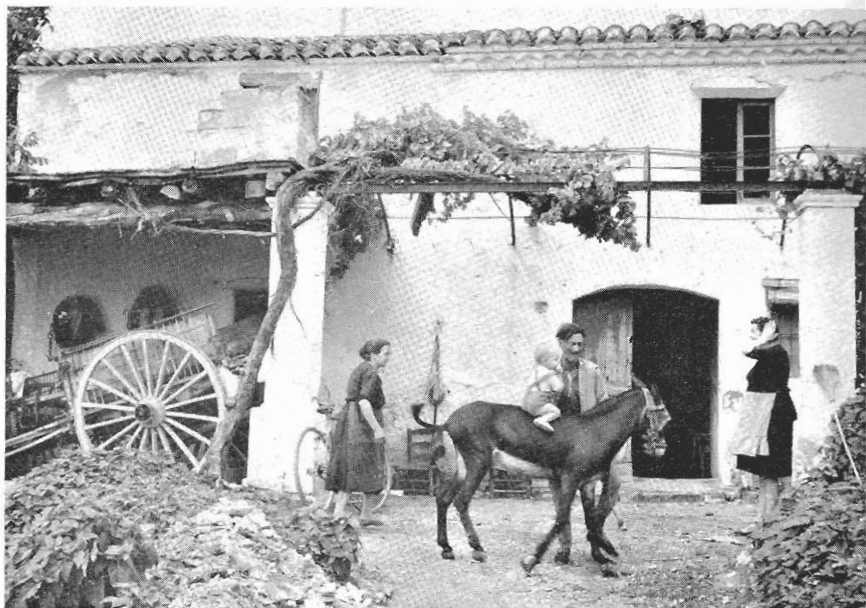
DIMORA RURALE TIPICA DELLA ZONA AGRARIA IRRIGUA DI PIANURA.
