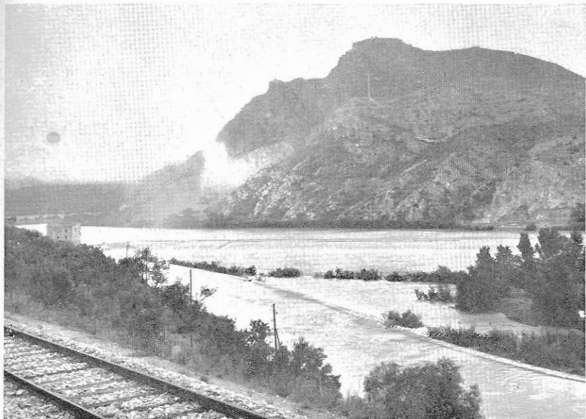
IL MEANDRO DELL'EBRO A CHERTA, CHE CONSENTE L'IMMISSIONE NATURALE DELLE ACQUE FLUVIALI NEI DUE GRANDI CANALI D'IRRIGAZIONE.
