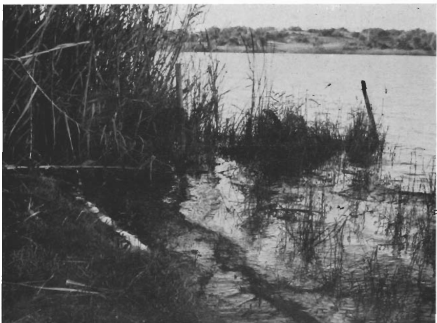
Pali di contenimento delle colmate eseguite nel 1935, rimasti isolati nelle acque che hanno asportato il materiale posto a ridosso di essi per rialzare il terreno.
