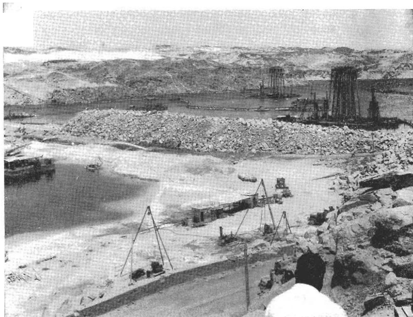
VEDUTA DEI LAVORI PER LA COSTRUZIONE DELL'ALTA DIGA. Sono in corso le operazioni per l'elevazione dello sbarramento principale
