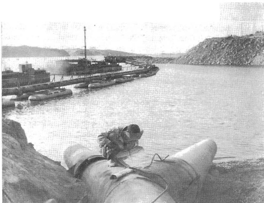
ALTRA VEDUTA DEI LAVORI PER LA COSTRUZIONE DELL'ALTA DIGA.
