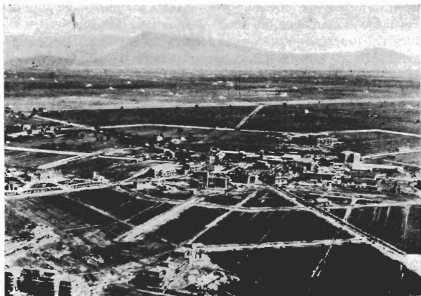
LA FASE INIZIALE DELLA COSTRUZIONE DI LATINA.
