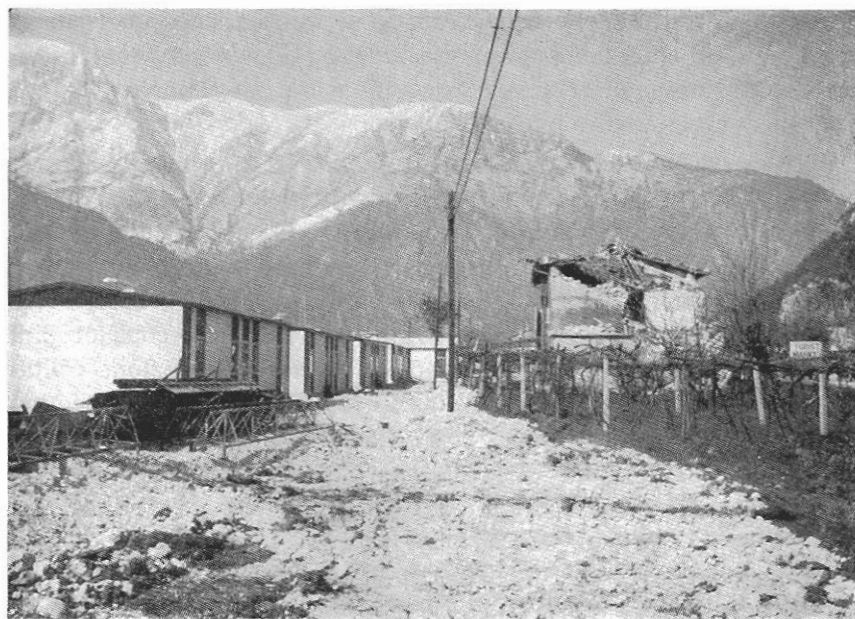
FIG. 4 — VILLAGGIO DI PREFABBRICATI A VENZONE.
