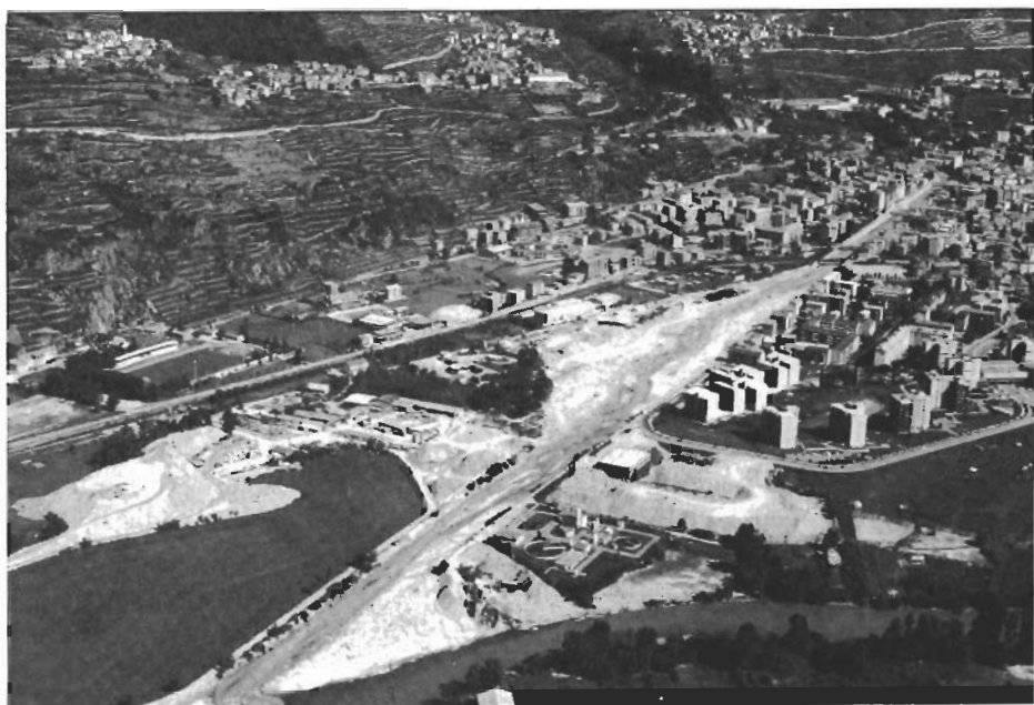
LA PERIFERIA OCCIDENTALE DI SONDRIO VISTA DALL'ELICOTTERO. È ben visibile il materiale depositato nell'area di confluenza tra Adda e Mallero.
