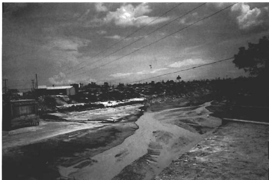
FIG. 5 – EFFETTI DELL'ERUZIONE DEL PINATUBO: UN PONTE SUL FIUME ABACAN, AD ANGELES CITY, DISTRUTTO DAL «LAHAR» (4 agosto 1991).
