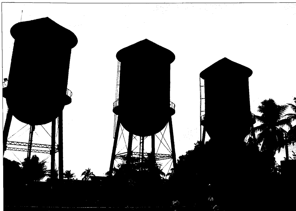
Fig. 2 – As Três Caixas d'Água
