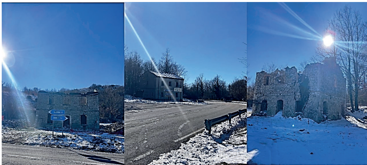
Figura 8. Alcune delle strutture dei caselli dismessi ancora visibili (fermata di Cassillo, Tre Termini, Rocca Tamburri). Fonte: foto di Giada Mastrostefano.
