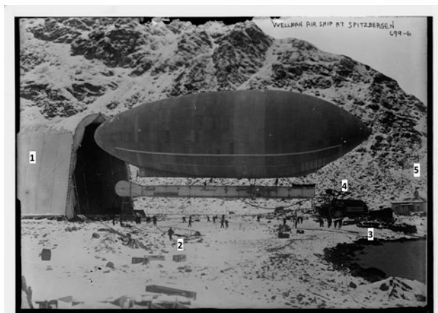
Figura 8. Il dirigibile America sulla spiaggia di Virgohamna, appena fuori dell'hangar [1], in una foto del 1907. In primo piano, nella neve, si intravede una struttura a traliccio che si ipotizza possa essere lo scheletro – privato del rivestimento in tela – della navicella di Godard (1906) [2]. Sulla destra si nota la grossa catasta di bidoni contenenti carburante [3], sullo sfondo dei locali tecnici [4] e della “Wellman’s Hut” [5]. Fonte: Norskpolarinstitutt.
