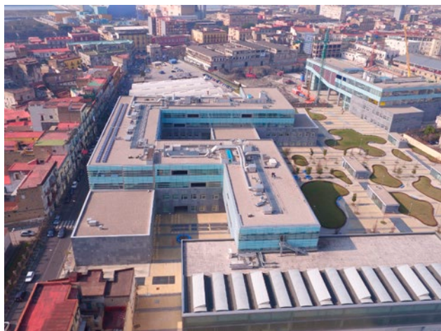
Figura 8. Area post insediamento universitario e Apple iOS Academy. Fonte: fotografia di proprietà di S. de Falco, realizzata nel settembre 2018 in alta definizione camera RAW con drone da società Helicavision con licenza Enac e autorizzazione dell'Università degli Studi di Napoli Federico II.
